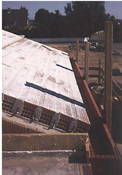
Verlegen der Elemente auf tragenden Wohnungstrennwänden einer Reihenanlage
