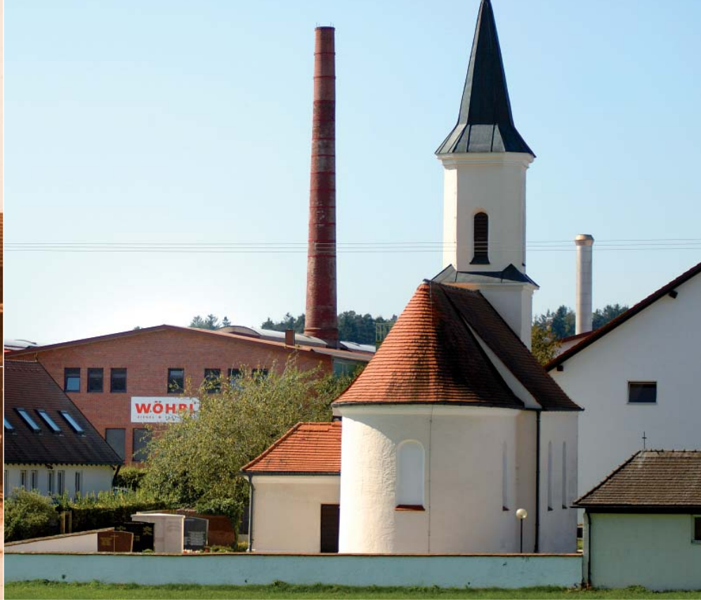
Standort der Wöhrl GmbH in Berghaselbach heute
