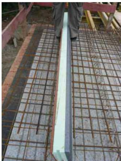
Vorbereiten der Elemente
