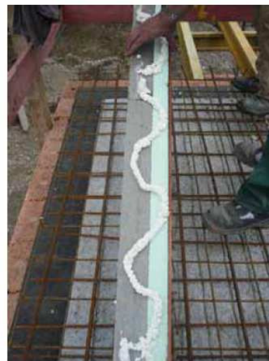
Auftrag „fingerdick“ in Schlangenlinien
