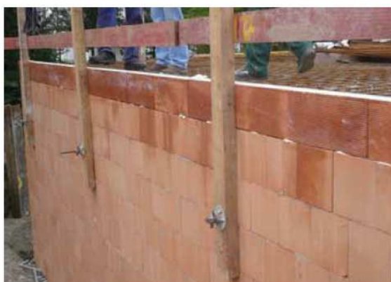
Deckenrandelemente fertig verlegt
