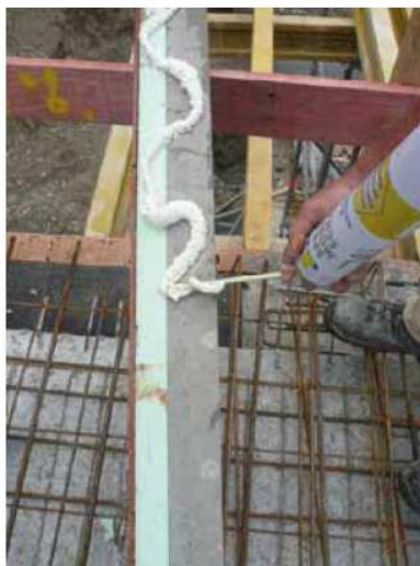
Auftragen des Spezial-PU-Schaumes
