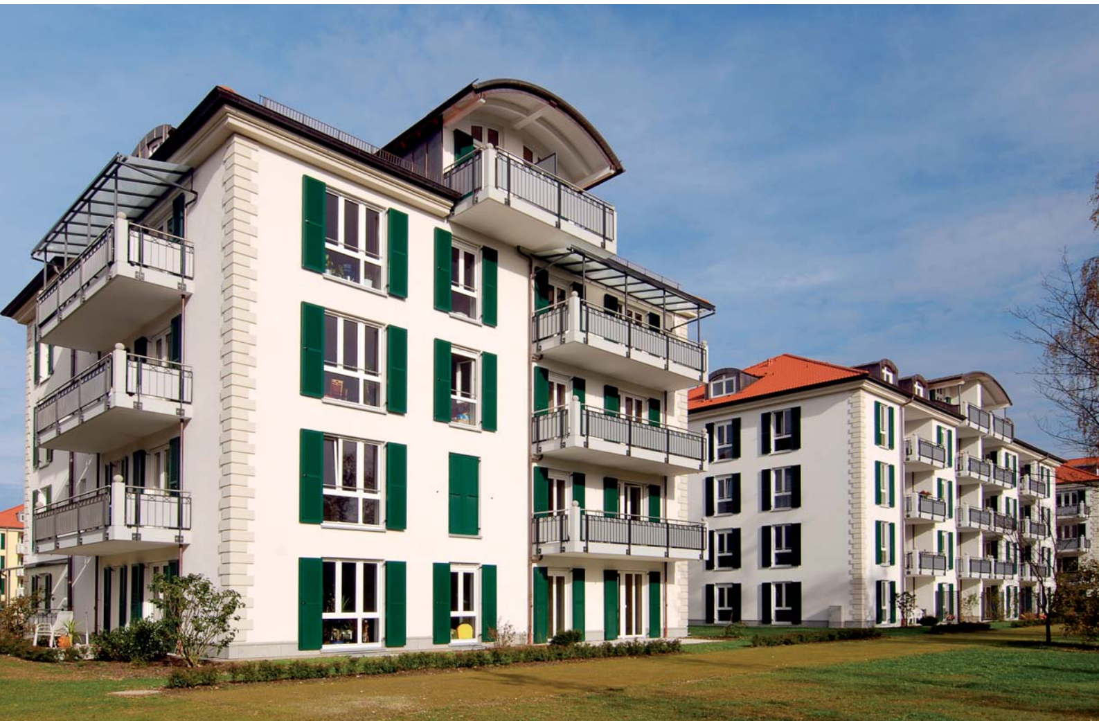
Fügt sich stimmig in die Umgebung ein: Die Wohnanlage für Staatsbedienstete im Münchener Stadtteil Nymphenburg umfasst zehn viergeschossige Ziegel-Gebäude.
