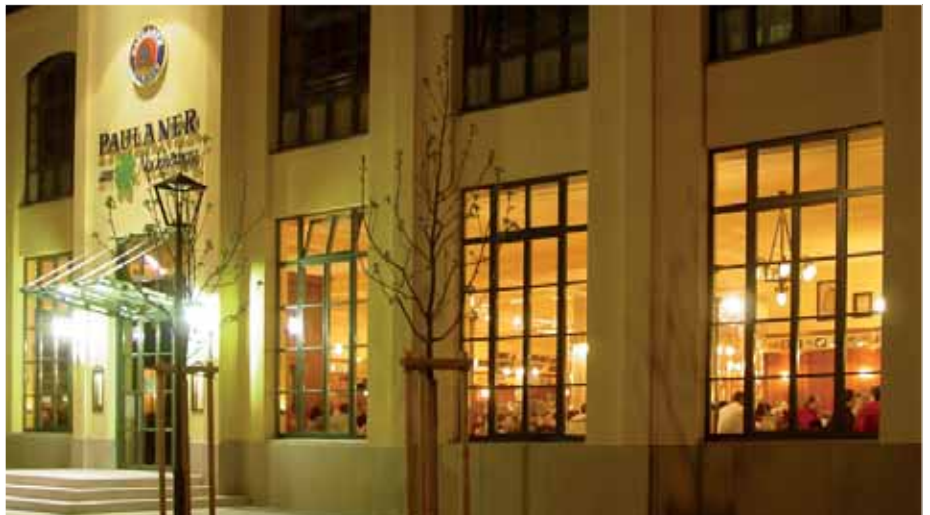
Der Wiederaufbau der Münchner Traditionsgaststätte Paulaner am Nockherberg wurde mit modernsten Ziegeln der Wöhrl GmbH realisiert
